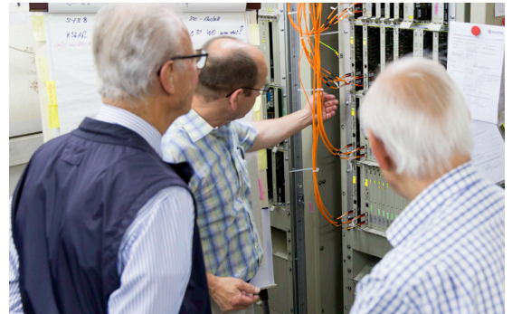
Abbildung 7. Benedikt Hopfgartner (Mitte) zeigt die CX22, angeschlossen via LWL im PLS80E Standard Systemschrank.
